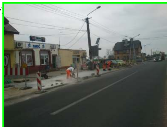
chodnik w Stolnie w trakcie budowy
