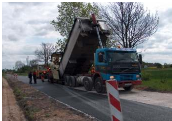
Fot. Prace wykonawcze
